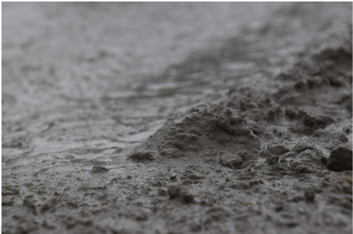
Foto: Detail betonmortel.
